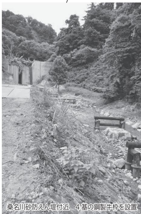
桑名川砂防えん堤付近 4基の鋼製牛枠を設置
