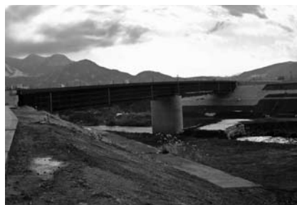
△現在工事中の「菜の花橋」。平成20年度の完成が待ち遠しいところです。
