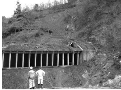
△今年3月には、雪解け時期の降雨で国道292号富倉トンネル付近の土砂が崩落。
