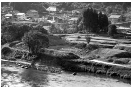
堤防の工事が進む桑名川地区
