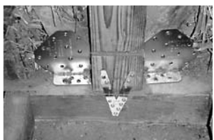
●金物による補強(柱・筋かい・土台の緊結)
