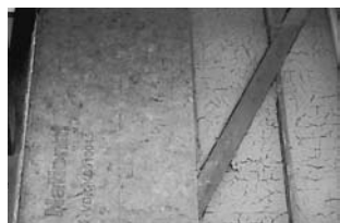
●耐震ボード(構造用合板)による補強
