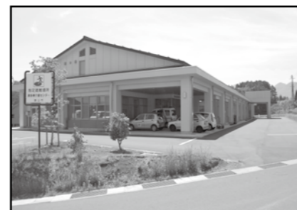
①北側からの外観
