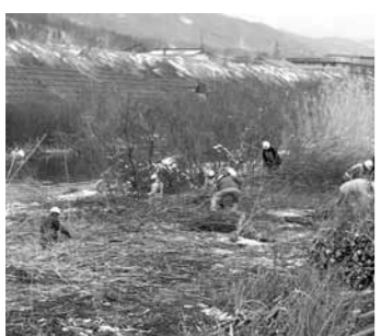
樽川堤防の草刈作業
