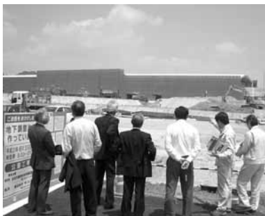
新玉名駅建設現場にて
