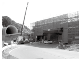
⑤斑尾線の上には高架橋がかけられ、工が進んでいます。
