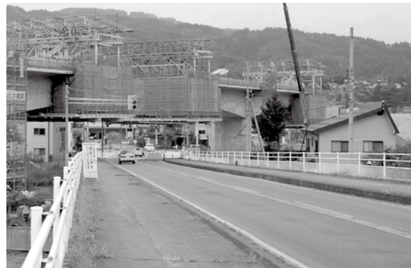
△現在工事中の高架橋。この県道飯山野沢温泉線の上に高架橋がかかります。（道路手前が綱切橋方面）
