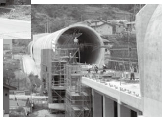
⑥現在の工事の様子（長峰トンネルから飯山トンネル方面に向かって撮影）
