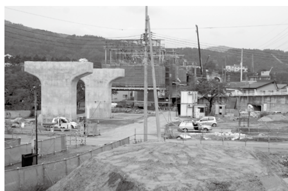
△新しい橋脚がいくつも立ち並ぶ光景は、新幹線開通への希望を抱かせてくれます。
