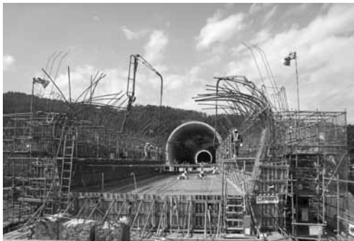
飯山トンネル入り口 工事が進む
