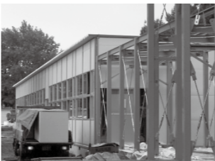
△現在の第一中学校校舎西側に増築工事の新しい教室。
