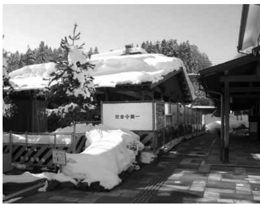
建設中の人形館
