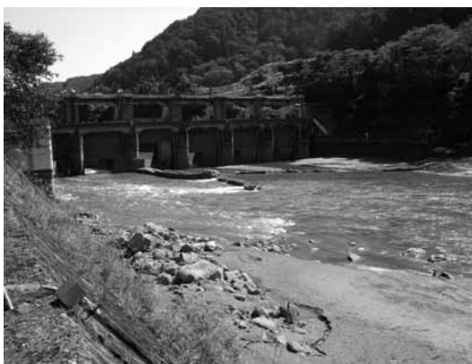
西大滝ダム放流時の堆砂状況
