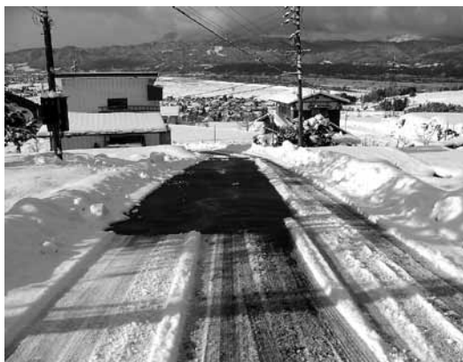
無散水融雪施設の路面の状況
