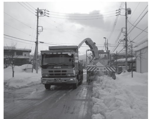
北町の無散水融雪施設個所の排雪作業状況
