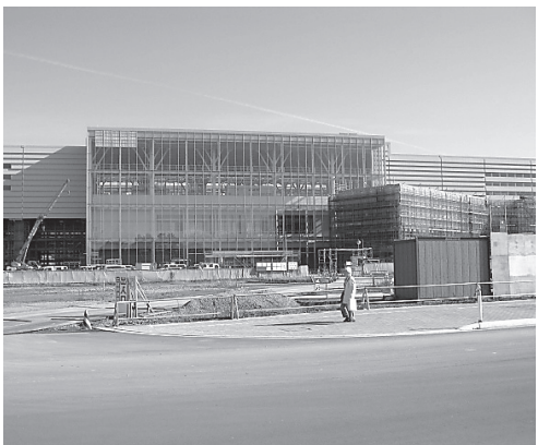
建設中の新青森駅
