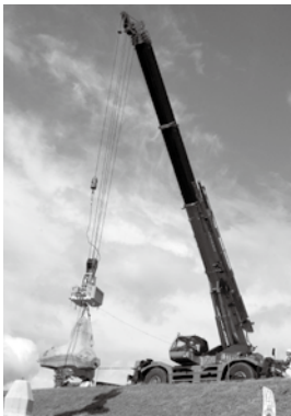
千曲川河川事務所によるクレーンを使った「大型ブロック投入訓練」
