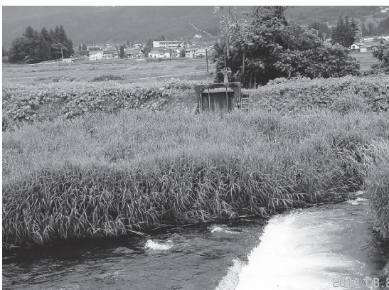
樽川よりの根越用水取入水門
