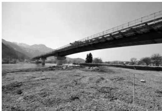
着々と進む新幹線工事 ～千曲川に架かる菜の花大橋～
