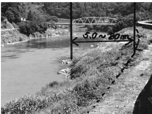
戸狩掘削場所
