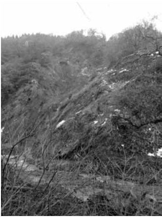
清川の崩落現場
