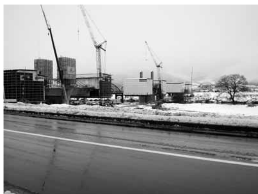
建設が進む中央橋
