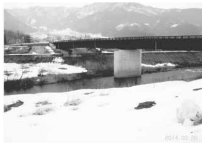
樽川橋下浚せつ力所
