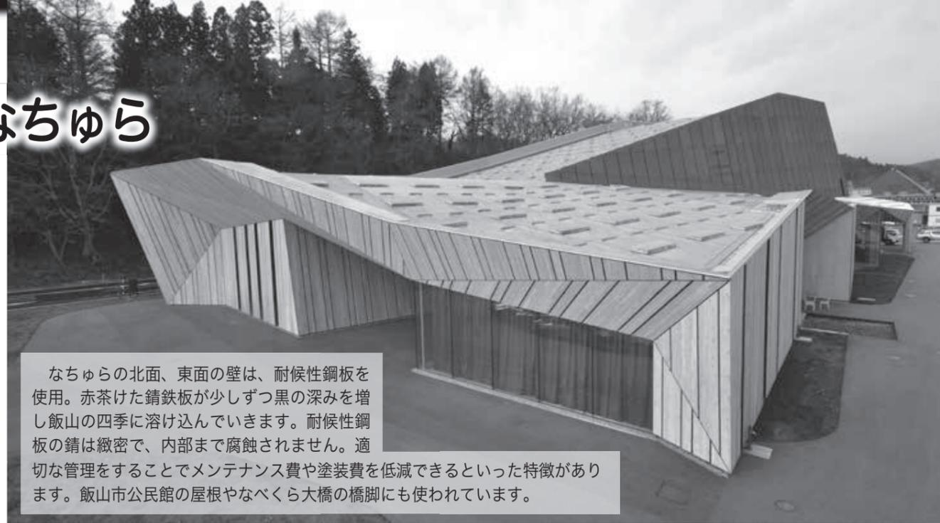
なちゅらの北面、東面の壁は、耐候性鋼板を使用。赤茶けた錆鉄板が少しずつ黒の深みを増し飯山の四季に溶け込んでいきます。耐候性鋼板の錆は緻密で、内部まで腐蝕されません。適切な管理をすることでメンテナンス費や塗装費を低減できるといった特徴があります。飯山市公民館の屋根やなべくら大橋の橋脚にも使われています。
