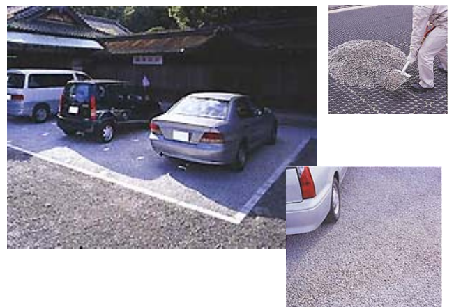
砂利舗装（樹脂のフレームに砂利を投入）
