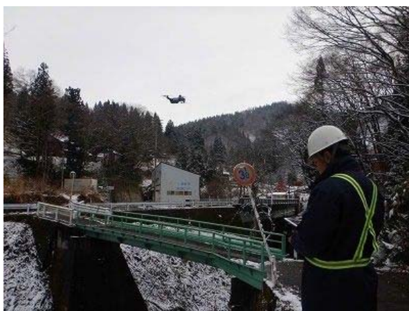
8-12号橋（古屋橋）でのドローン活用による点検作業の様子
