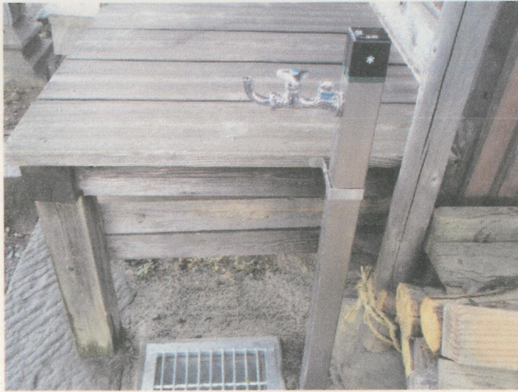
③水道敷設工事完了
