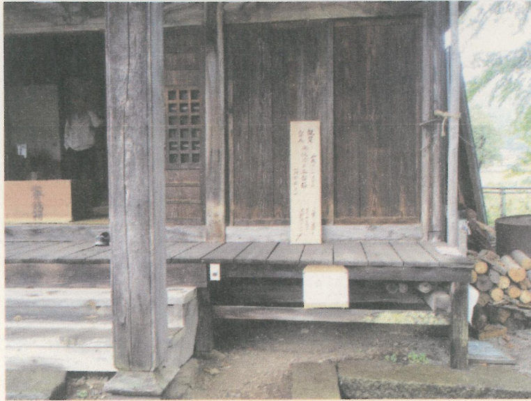
⑤親鸞聖人説法の石説明版・照明設置
