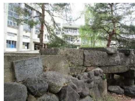
平用水 石樋 (旧常盤小学校)
