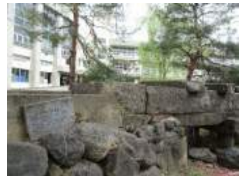
平用水 石樋（旧常盤小学校）
