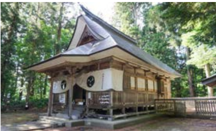
里宮 本殿 外観
