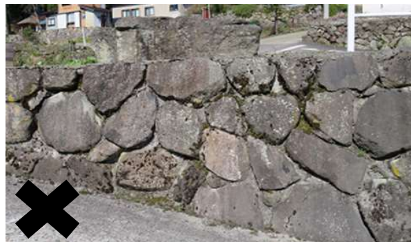
受け継がれてきた石垣の景観を損ねてしまう積み方
