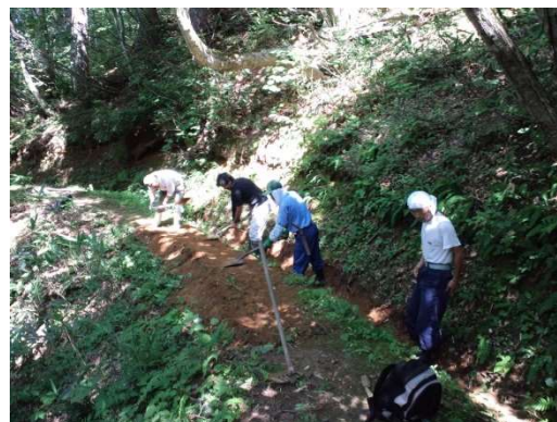
春や秋には用水共有地委員会を中心に水路の清掃・点検が行われる
