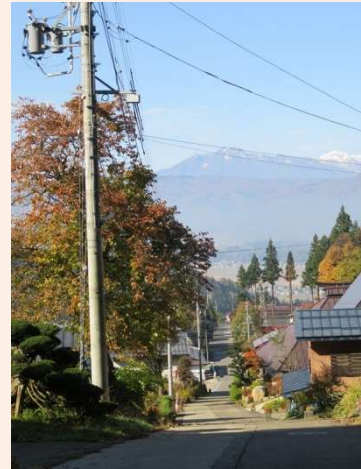
景観を阻害している電柱や電線
