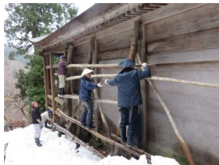
奥社本殿の雪囲い外し作業
