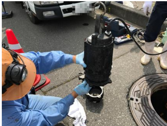
マンホールポンプ点検状況
