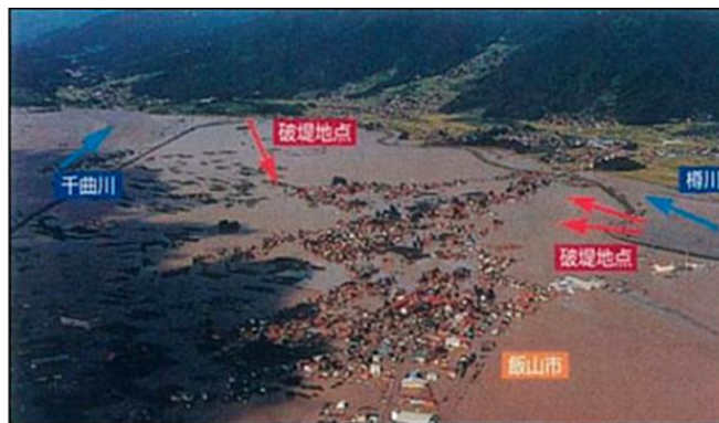
樽川の破堤状況
