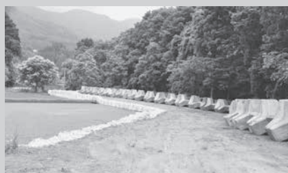
緊急で大型土のうやブロック積み等の応急処置
