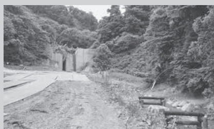
砂防えん堤付近では鋼製牛枠等の設置が行われる（鋼製牛枠とは、土石流の流向制御や流木の捕捉等に利用できる小型の鋼製構造物です）
