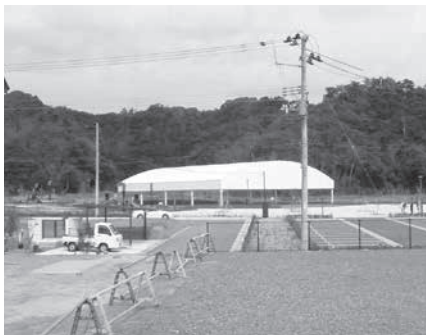
屋根付き広場兼防災シェルター
