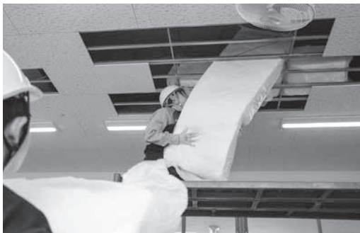
天井裏に断熱材を敷き詰める城南中学校の生徒
