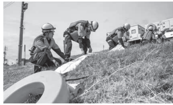
宮沢川樋門で排水ポンプの設置訓練を実施
