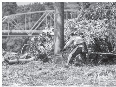
河川敷で樹木を伐採する作業員
