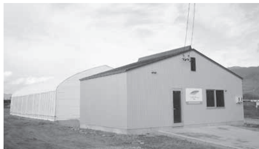
木島工業団地にある平屋建ての作業所とパイプハウス。作業所には、トイレ、水場、空調を設備。
