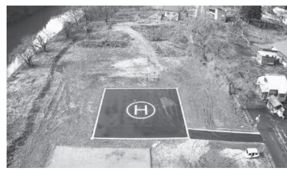
設置されたヘリポート
