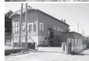
◀飯山小学校の東にある城山雨水排水ポンプ場外観
