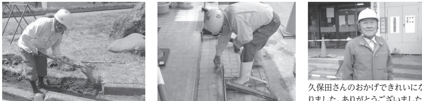
久保田 一英さんによる青少年ホームの修繕工事の様子 (5月13日)
