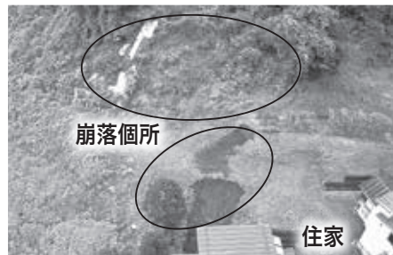
▲吉区の土砂崩落個所の一部分
