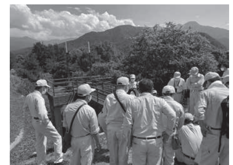
飯山城南樋管
