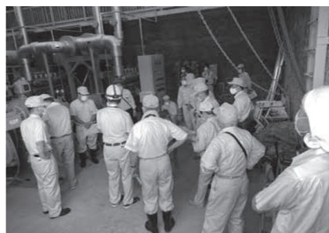
城山雨水排水ポンプ場内
