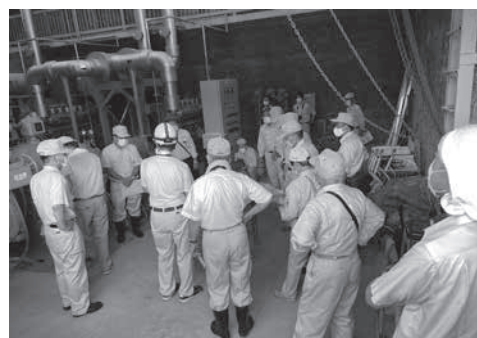
城山雨水排水ポンプ場内
