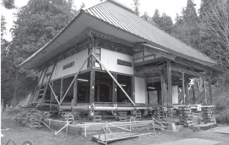
壁や床板が取り除かれジャッキアップされた護摩堂
