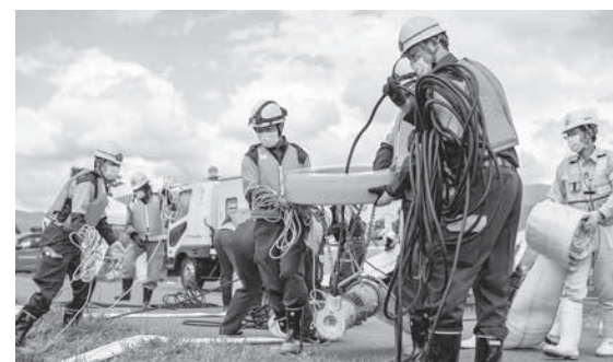
市排水ポンプ車の水中ポンプとホースを運ぶ団員
