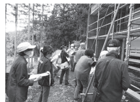
工事中の護摩堂を見学する参加者
