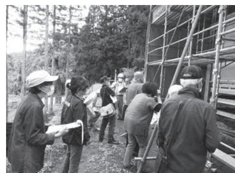
工事中の護摩堂を見学する参加者
