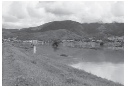
常盤地区堤外の畑が浸水している様子(道の駅花の駅千曲川付近)
