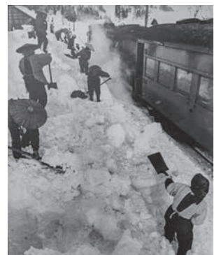
桑名川駅付近での除雪作業(昭和43年)
