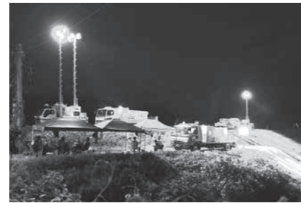
夜間、今井川樋門で稼働している排水ポンプ車と待機している第9分団消防団員
