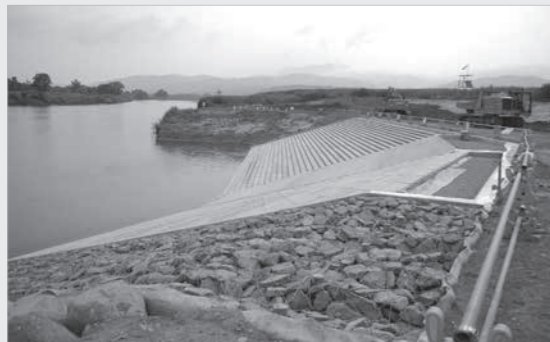
親水護岸（カヌーポート）整備工事現場
