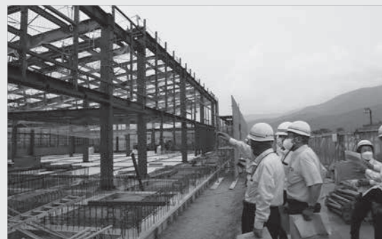
道の駅建設工事現場
