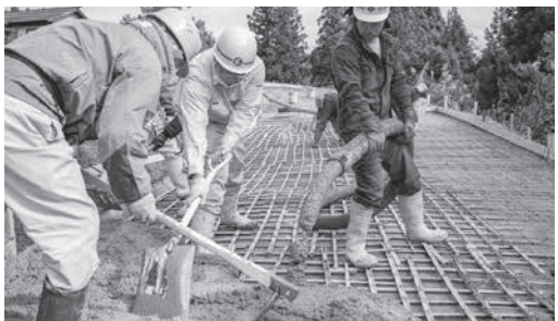
竹を縦に半分に割り、20センチ間隔で格子状に組み立てたところに、コンクリートを流し込んでいる様子
