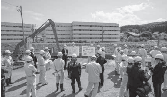
皿川の工事現場付近で担当職員から説明を受ける参加者
